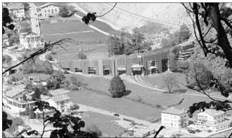
Der Kreisviadukt von Brusio muss nach über 100 Jahren umfassend instand gesetzt werden. (zVg)
